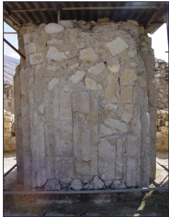
تصویر ۱۶. حفاظت از گچبری‌های حیاط موزاییک توسط داربست و پوشش موقت (عکس از: شاه محمدپور، ۱۳۸۹).
